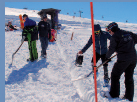
▲ Speyerer Rennläufer helfen beim Aufbau des Starts: Das Kabel zum Startzelt muss eingegraben werden
