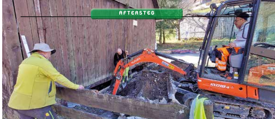
Mit „schwerem Gerät“ der Firma Schön wird das Gelände hinter dem Schuppen aufgedigelt um die Rückwand zu richten.
