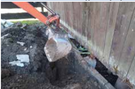
Nach dem Freilegen der Rückwand wird der Schaden sichtbar. Der verschobene Pfosten wird mit dem Bagger herausgezogen.
