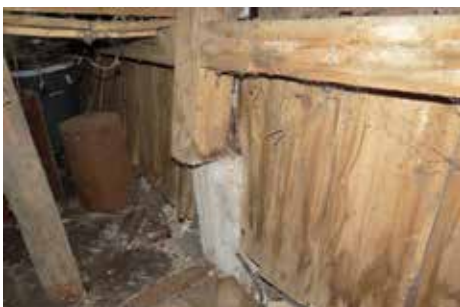
Nach dem Freilegen der Rückwand wird der Schaden sichtbar. Der verschobene Pfosten wird mit dem Bagger herausgezogen.
