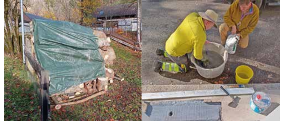
Das Holz wird auf dem oberen Parkplatz aufgeschichtet und abgedeckt; Jochen Schön setzt den Hauseingang instand.
