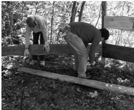
Peter Stepp montiert die Pfosten in die Metallschuhe; Peter Mehn und Matze Urban schrauben die Bretter an.
