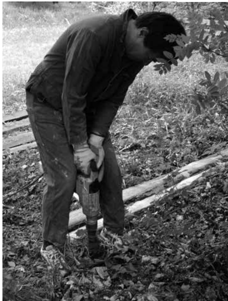
Fast wie im Winter: Hannes Stepp an der Bohrmaschine beim Vorbohren der Löcher für die Metallschuhe.
