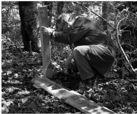
Peter Stepp montiert die Pfosten in die Metallschuhe; Peter Mehn und Matze Urban schrauben die Bretter an.
