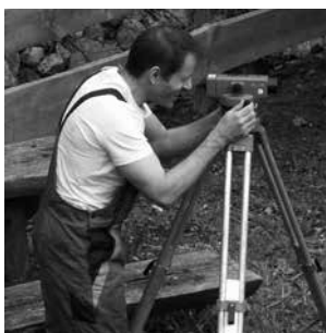
▲ Exakt: Lutz Höring beim Nivellieren der Fundamente.
