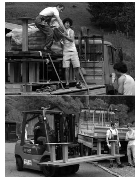
Spät, aber nicht zu spät: Nachdem die 40-kg-schweren Zementsäcke mühsam abgeladen waren, kam der benachbarte Dachdecker Strittmatter mit seinem Gabelstapler zu Hilfe, um die Garnituren zu transportieren.
